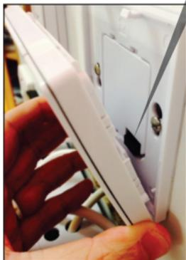
**1** Richten Sie das vordere Gehäuse an der unteren Kante aus.
