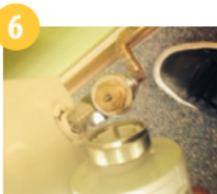
Platzieren Sie den TRV über dem Radiatorventil.
